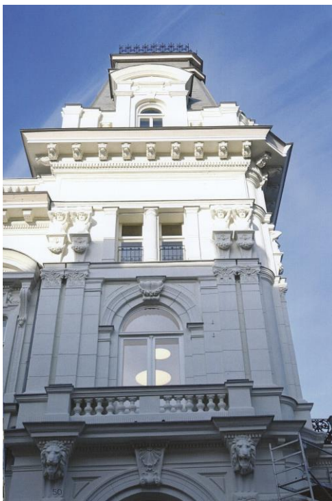
Tóth Péter-palota – A külső homlokzat (részlet) (Fotó: FERROÉP)
