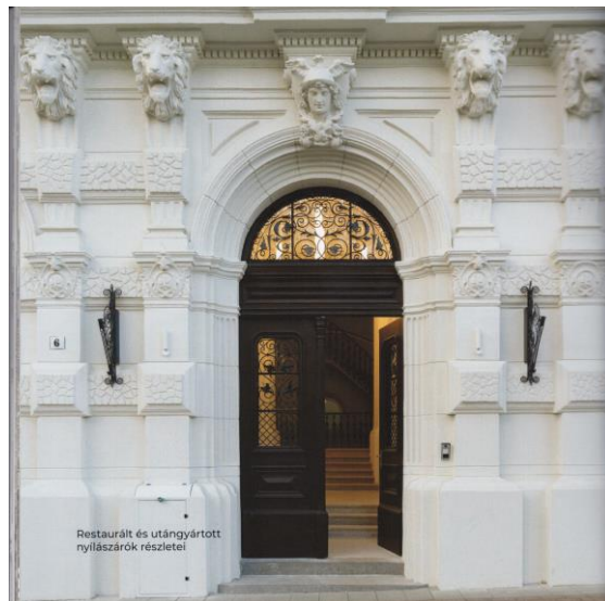
Tóth Péter-palota – A restaurált oldal bejárata (Fotó: FERROÉP)
